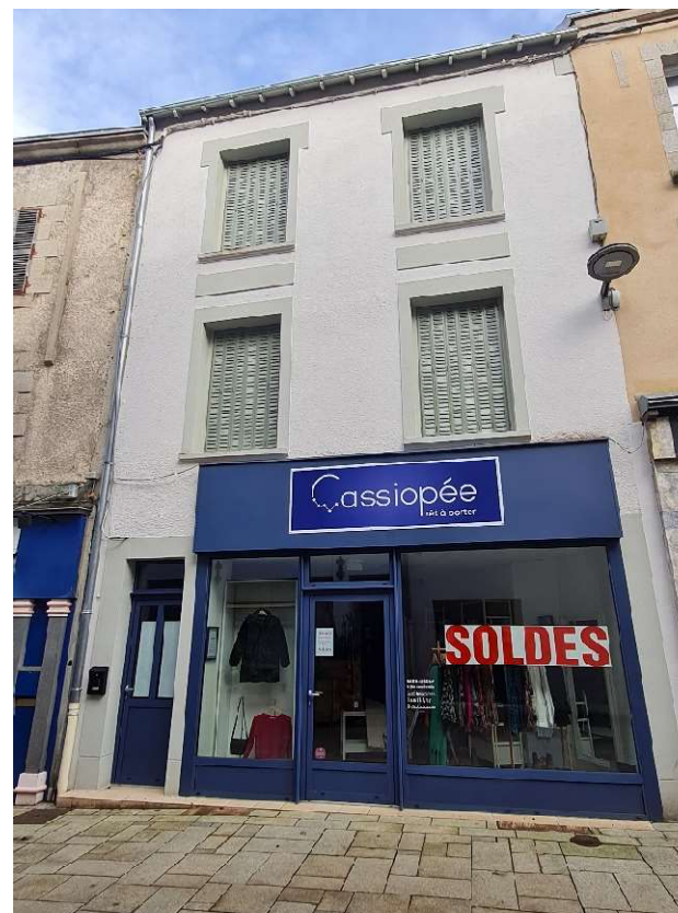
Photo après rénovation du local commercial et façade par la collectivité
